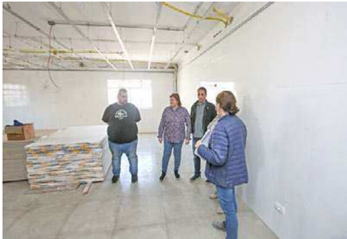
Prefeita da Cidade, Raquel Chini, vistoriou o andamento das obras na quarta-feira (3)
