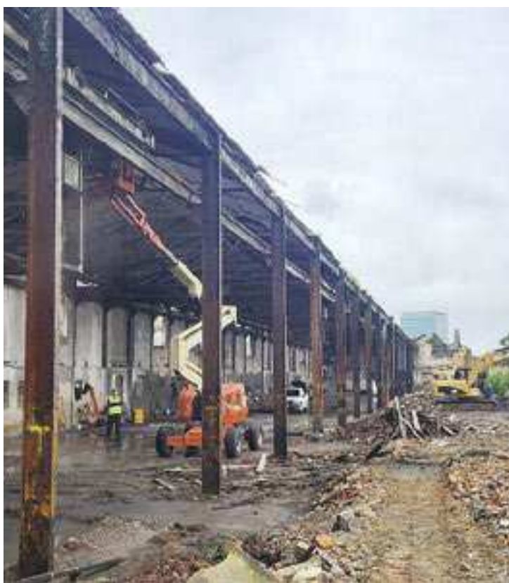
Serviços incluem limpeza de vegetação, execução da linha de drenagem e colocação de eletrodutos de elétrica para iluminação
