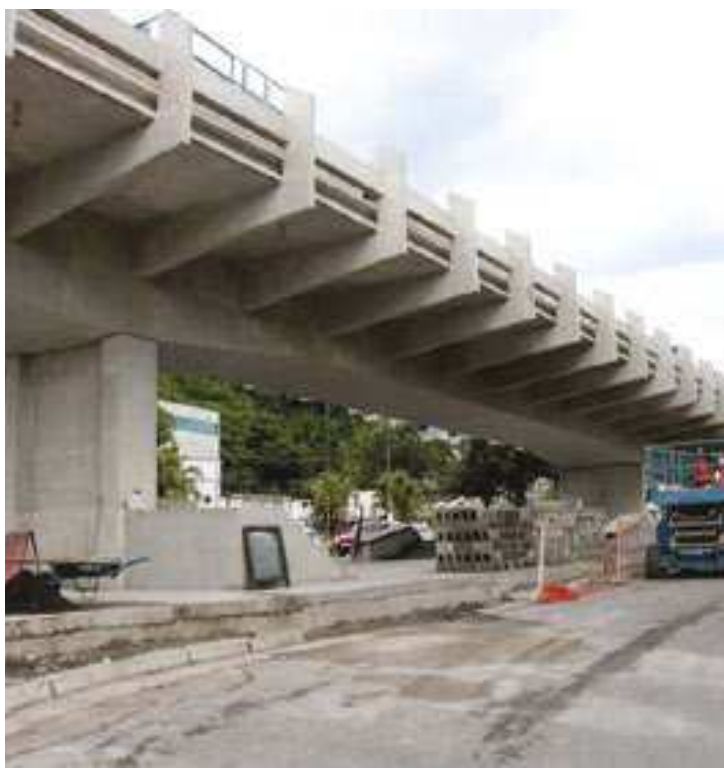
Estrutura do viaduto está sendo recuperada e restaurada
