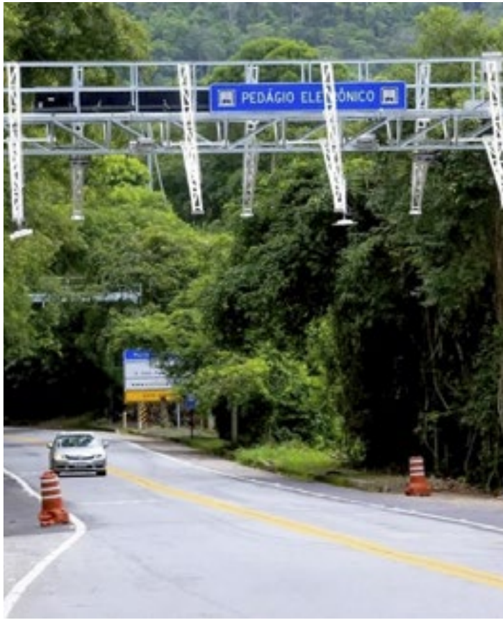
Os equipamentos ficarão nas novas entradas e saídas das pistas marginais para as expressas em construção atualmente
