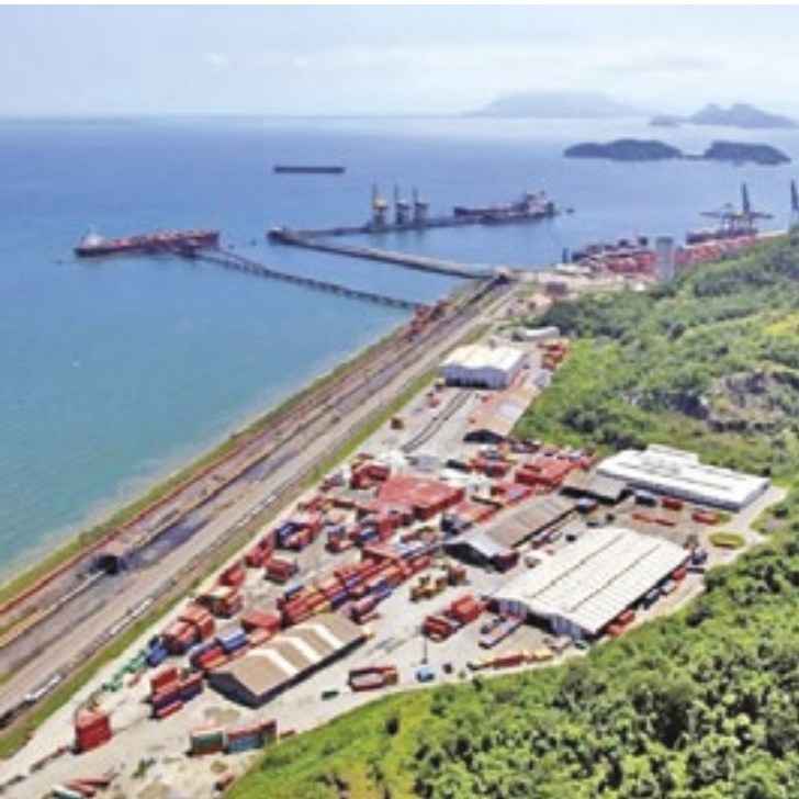
Em Itaguaí, o governo vai licitar a construção de um terminal que será erguido do zero, para receber minério de ferro
